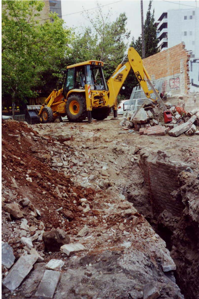
FOTO 2: Imatge de l'excavació de la Rasa 3 mitjançant la pala retroexcavadora.
